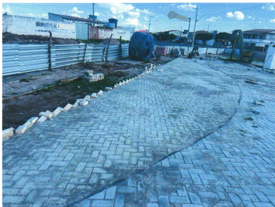
Foto 04 - Pavimentação em bloco de concreto vibroprensado, intertravado, colorido, 10x20cm, e=6cm, 46un/m 2 , NBR9781, Fck(min)=35MPa, sob coxim areia grossa compactada c/ placa vibratória, e(comp.)=6cm, rejuntado c/ areia fina.
